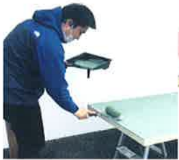
↑ 店内の仕切り壁を塗りました。すごくいい色に仕上がりました。
